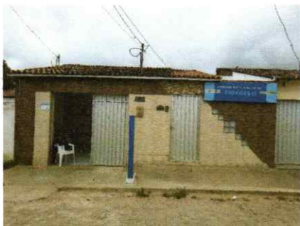
Foto 01- Fachada do imóvel
