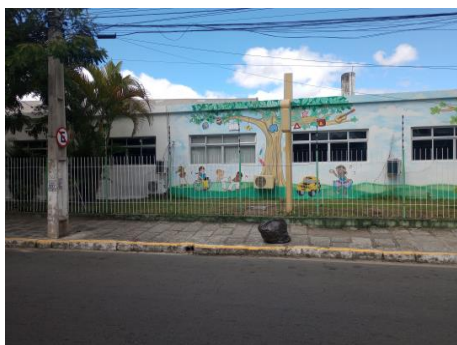
Foto 01- Fachada do imóvel
