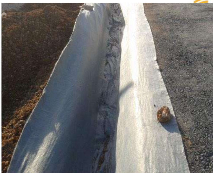
Figura - Colocação da manta geotêxtil.
