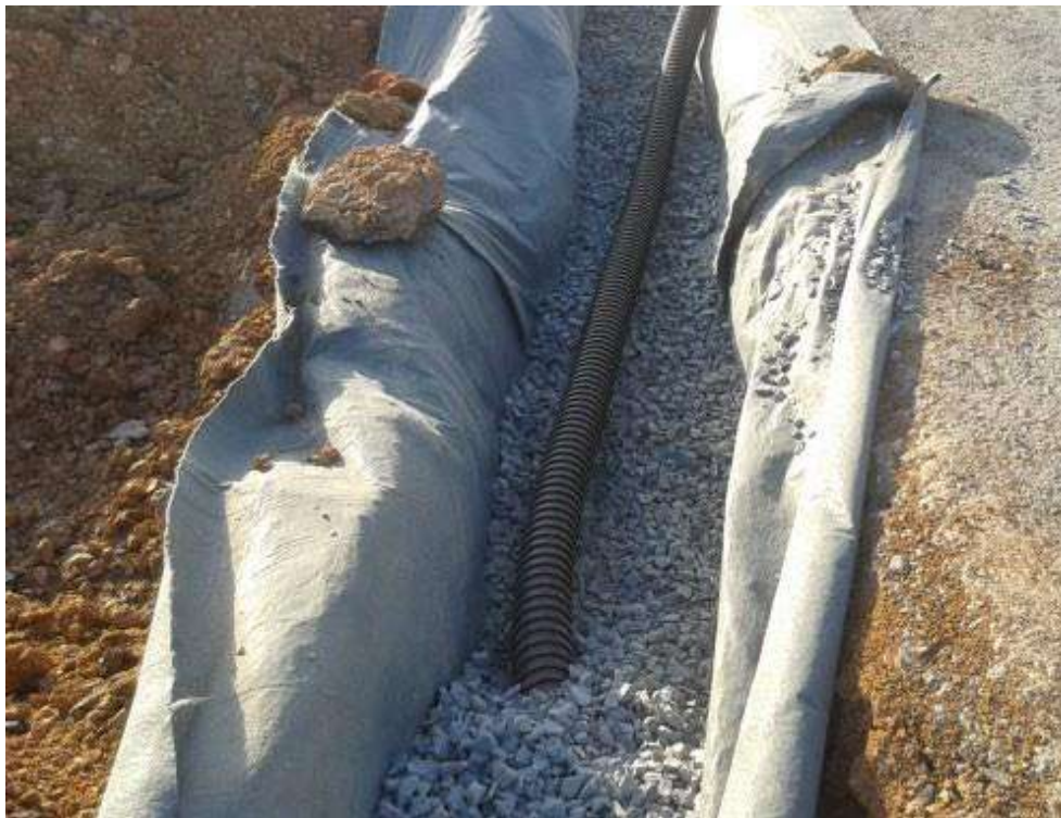
Colocação da brita sobre a manta geotêxtil.
