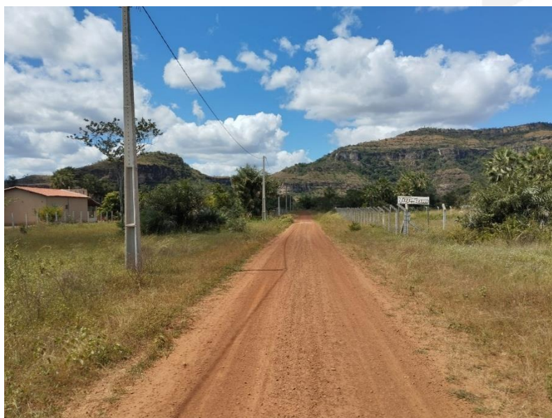
Via a Ser Pavimentada – Prox. Estaca 07
