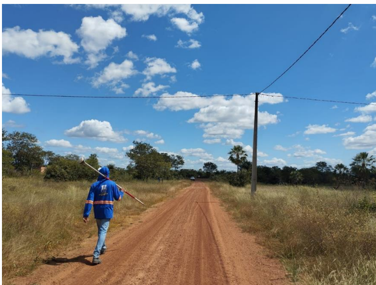
Via a Ser Pavimentada - Início
