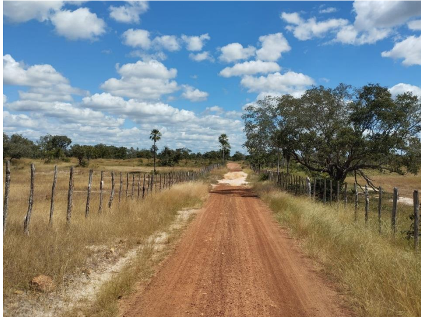
Via a ser pavimentada – Prox. Est 46 (localização BSTC 02)
