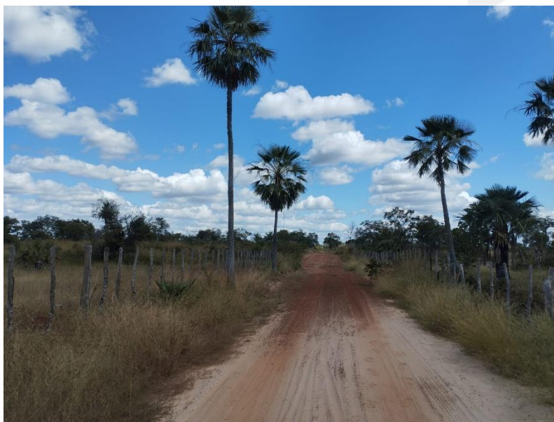
Via a ser pavimentada – Prox. Est 44
