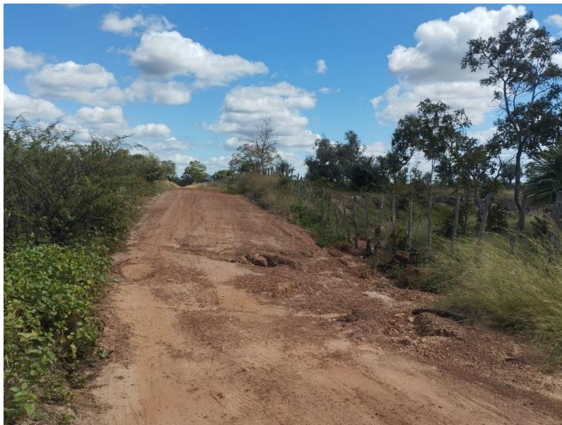
Via a ser pavimentada – Prox. Est 40 (localização BSTC 01)
