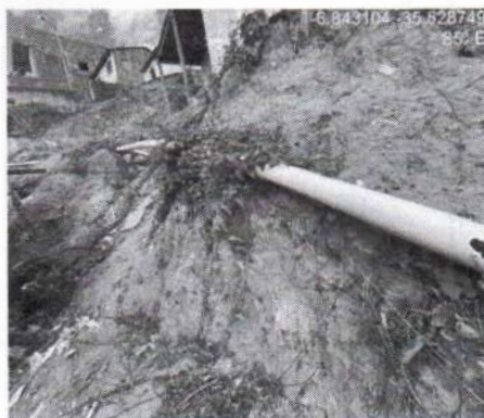
Imagem 10 - Realização de proteção de taludes para contenção
