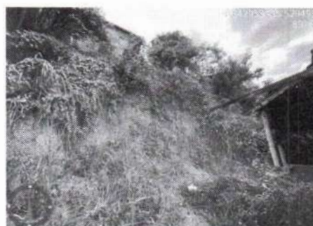
Imagem 2 - Realização de proteção de taludes para contenção
