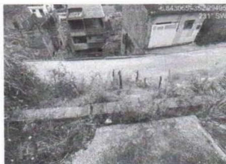
Imagem 5 - Realização de proteção de taludes para contenção
