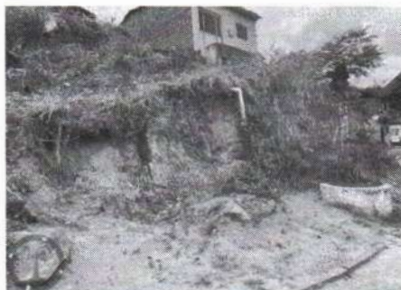
Imagem 11 - Realização de proteção de taludes para contenção
