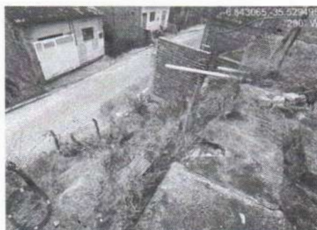
Imagem 1 - Realização de proteção de taludes para contenção
