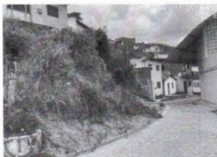
Imagem 6 - Realização de proteção de taludes para contenção
