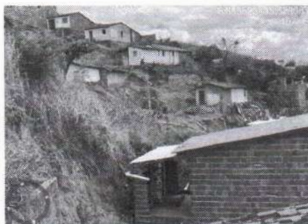
Imagem 7 - Realização de proteção de taludes para contenção
