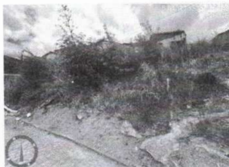
Imagem 4 - Realização de proteção de taludes para contenção
