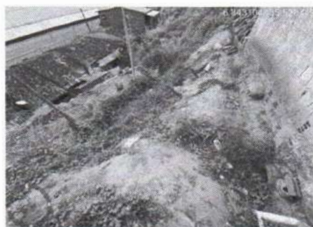
Imagem 8 - Realização de proteção de taludes para contenção
