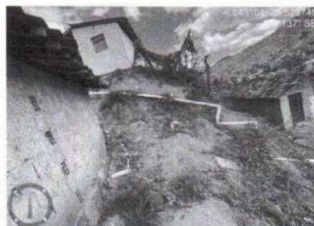
Imagem 9 - Realização de proteção de taludes para contenção
