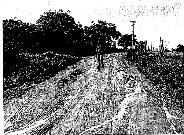
Sítio Jurema - final do trecho 2 Coord.: -7.404205,-35.543168
