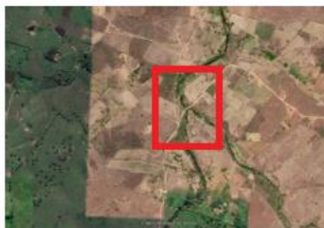
LOCALIZAÇÃO DO PONTO DA PASSAGEM MOLHADA
