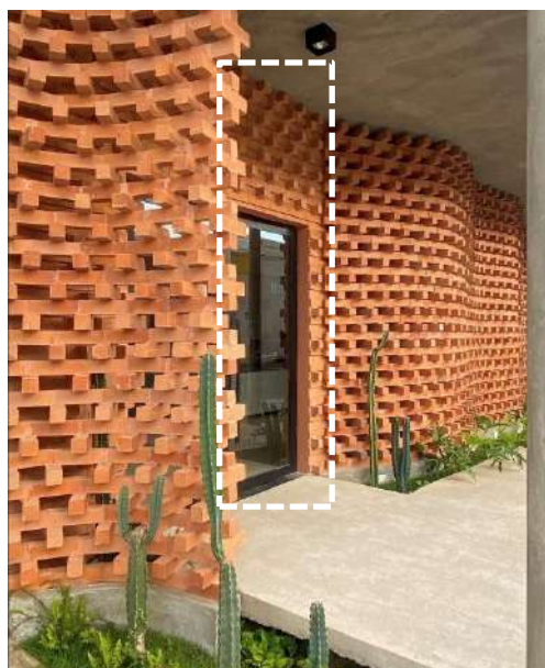
Figuras 32: Detalhe do assentamento na esquadria.
