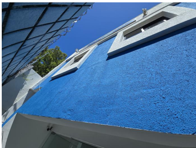
Imagem 1 – Área para fixação do toldo
