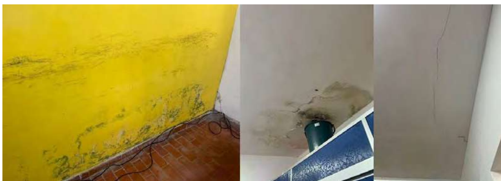
Figura 3 – Infiltração e fissuras
