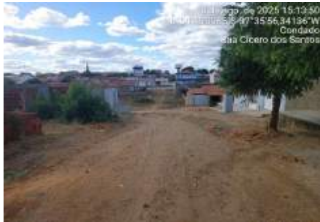
RUA PROJETADA F - TRECHO 01
