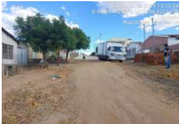
RUA PROJETADA F - TRECHO 01
