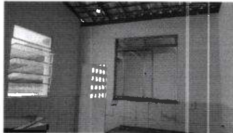
ÁREA EXTERNA DA COZINHA SUPERIOR
