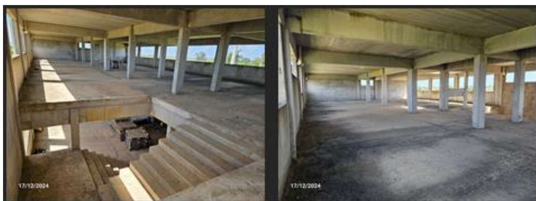
Imagens internas 3º pavimento
