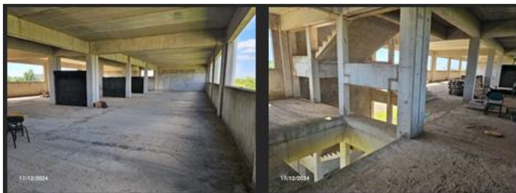
Imagens internas 2º pavimento
