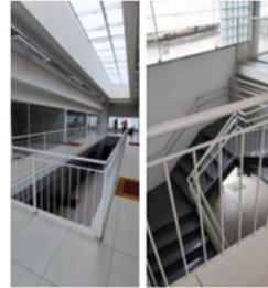
Espaço da escada e local para inserir plataforma elevatória na frente da escada de acesso, para acessibilidade
