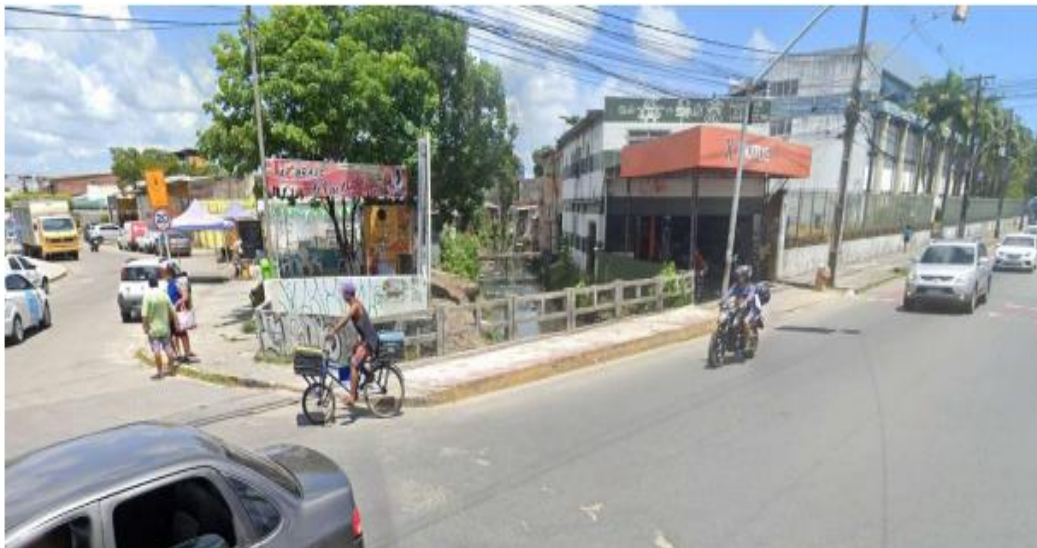
Figura 10: Canal da Mauricéia Visto da Rua Jean Emile Favre (Trecho 2)
