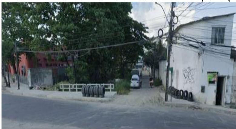
Figura 9: Canal da Mauricéia no Pontilhão da Rua Pampulha (Trecho 1)
