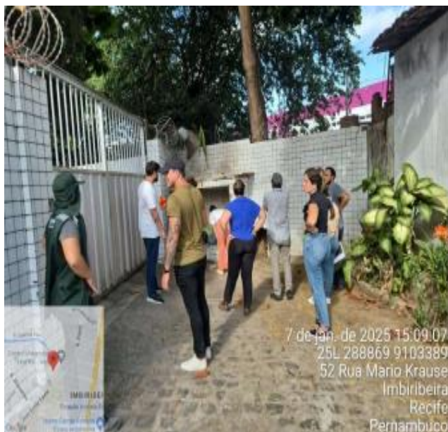
Figura 12: Rua Araraquara com Acesso ao Canal Bloqueado Por Muro (Trecho 2)
