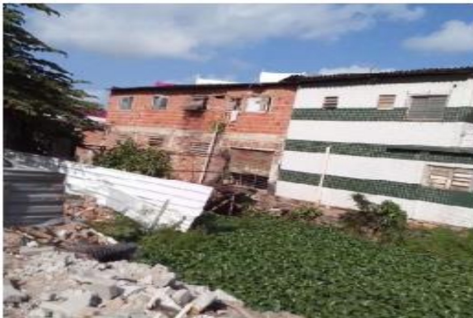
Figura 11: Canal da Mauricéia visto do pontilhão da Rua Jean Emile Favre (Trecho 2)
