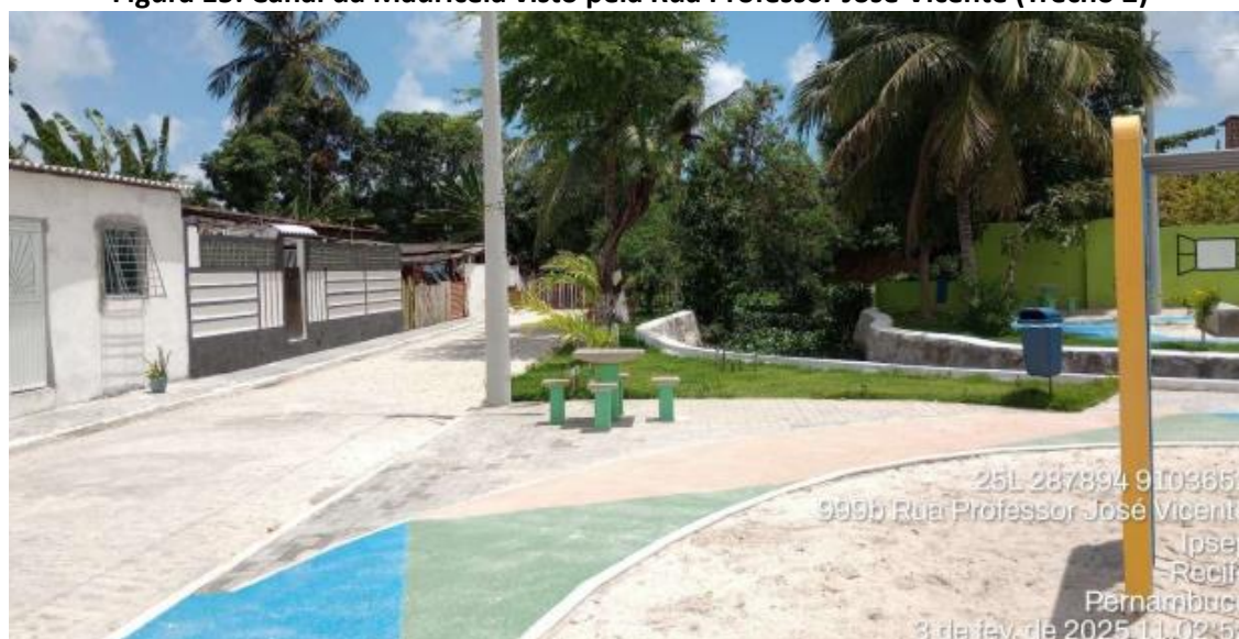
Figura 15: Canal da Mauricéia visto pela Rua Professor José Vicente (Trecho 2)
