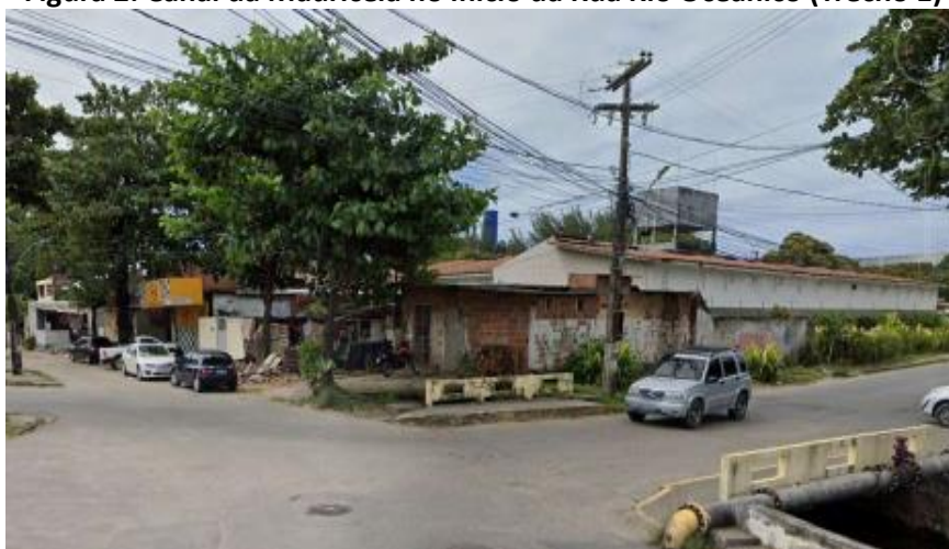
Figura 2: Canal da Mauricéia no início da Rua Rio Oceânico (Trecho 1)
