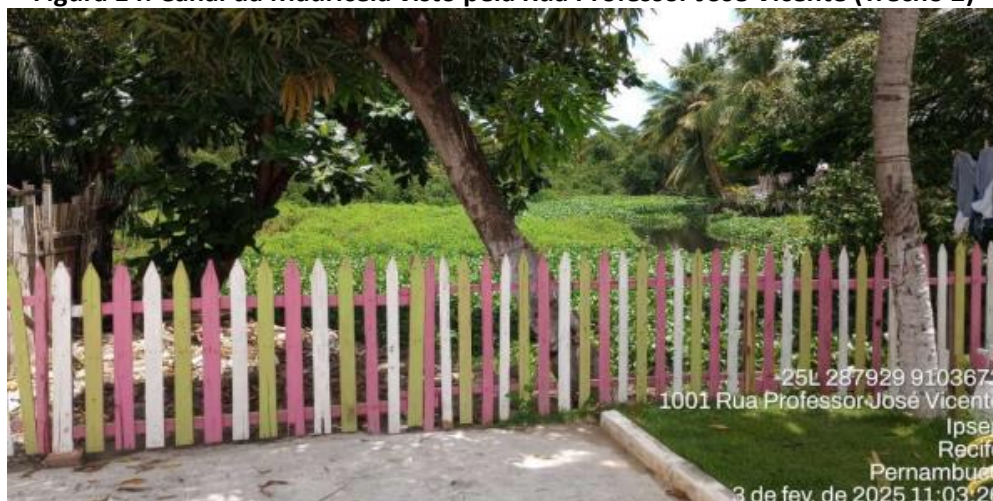
Figura 14: Canal da Mauricéia visto pela Rua Professor José Vicente (Trecho 2)
