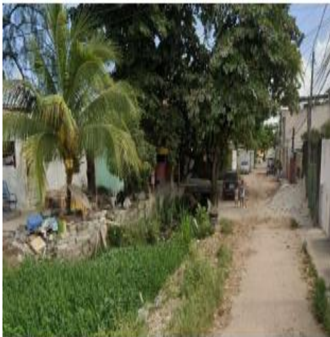
Figura 3: Canal da Mauricéia no início da Rua Rio Oceânico (Trecho 1)
