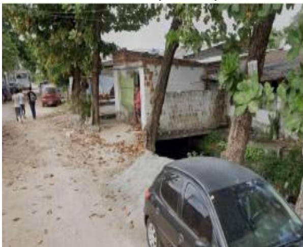
Figura 5: Edificação construída sobre o Canal da Mauricéia (Trecho 1)
