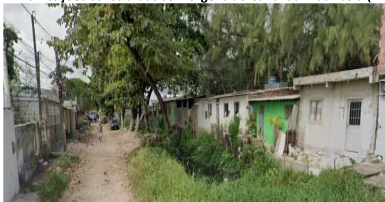
Figura 7: Edificações construídas às margens do Canal da Mauricéia (Trecho 1)
