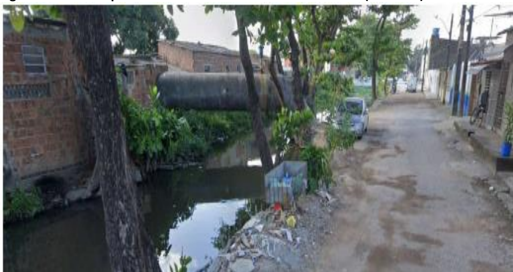
Figura 8: Adutora que atravessa o canal na Rua Rio Oceânico (Trecho 1)
