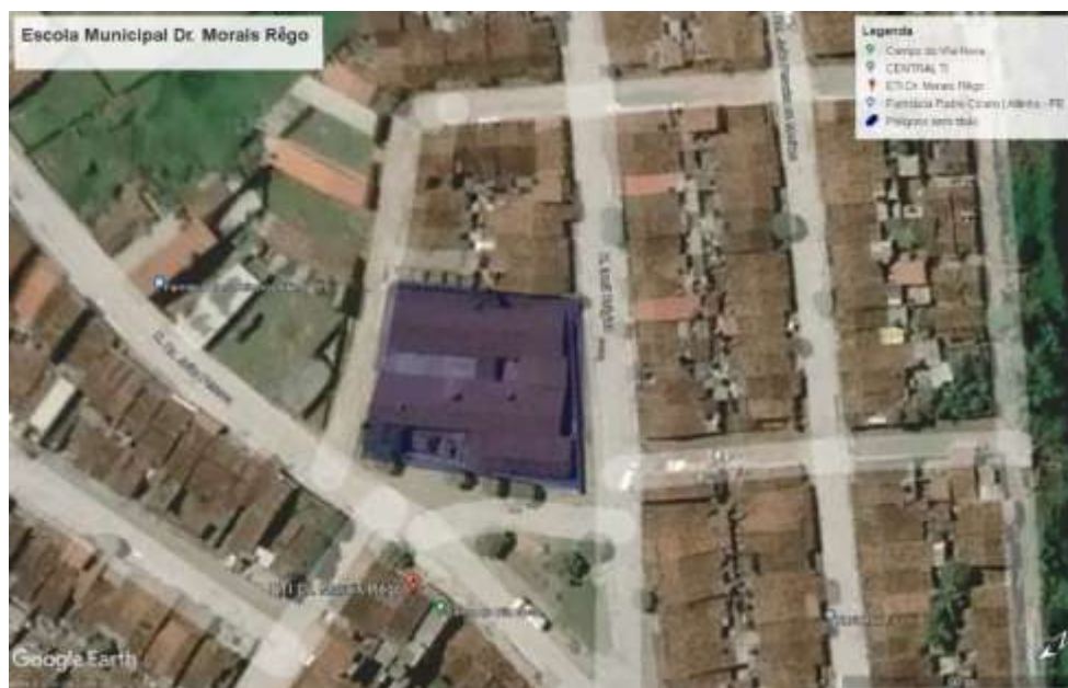
Figura 1 – Área de Implantação da Obra
