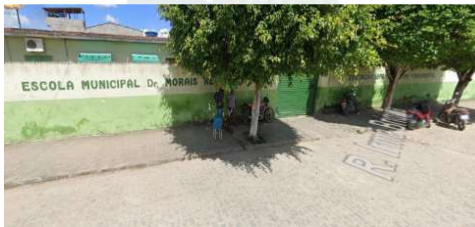
Figura 2 – Fachada da Edificação
