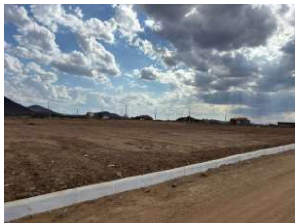
FOTO 06: TERRENO PARA ESPAÇO ESPORTIVO COMUNITÁRIO;
