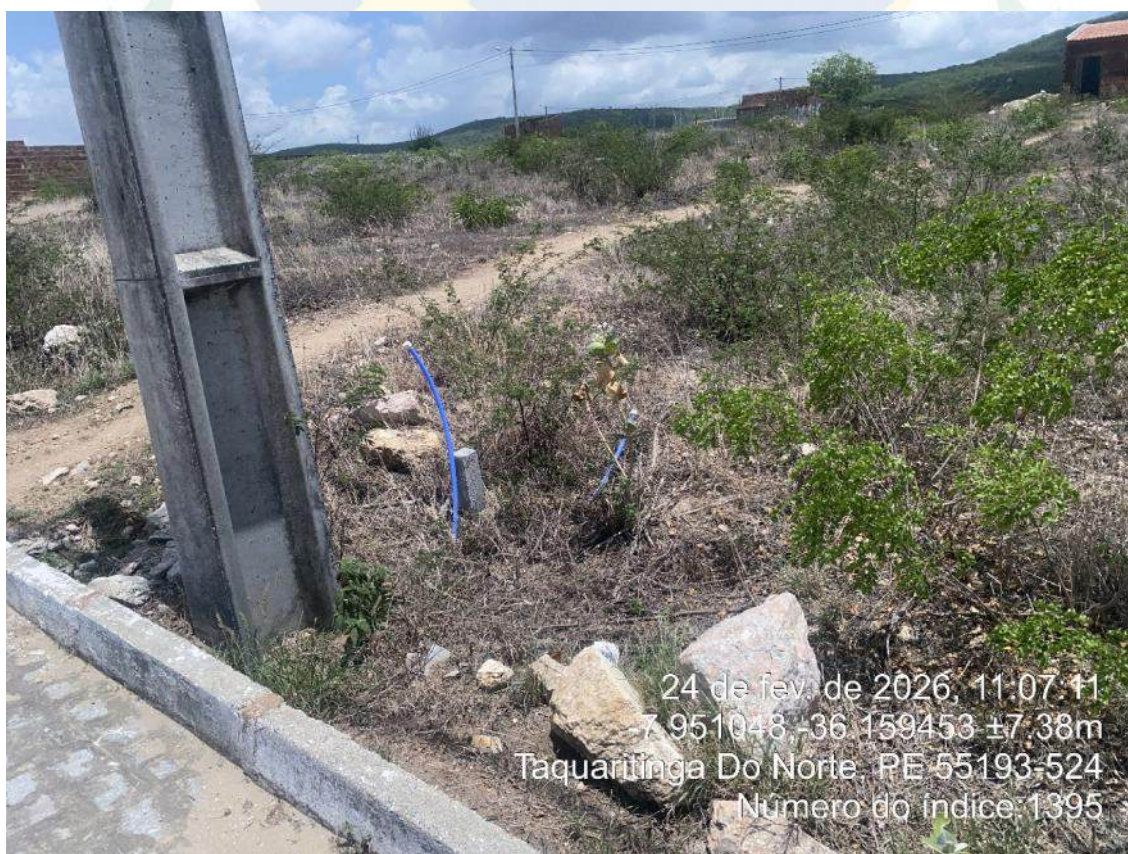
Foto 20: Imagem mostrando os pontos de espera para ligação individual dos lotes, caracterizando a existência da tubulação principal nas ruas do loteamento.
