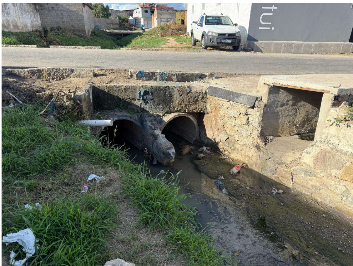
Figura 4-5 – Exemplo de travessia existente sobre a calha do canal
