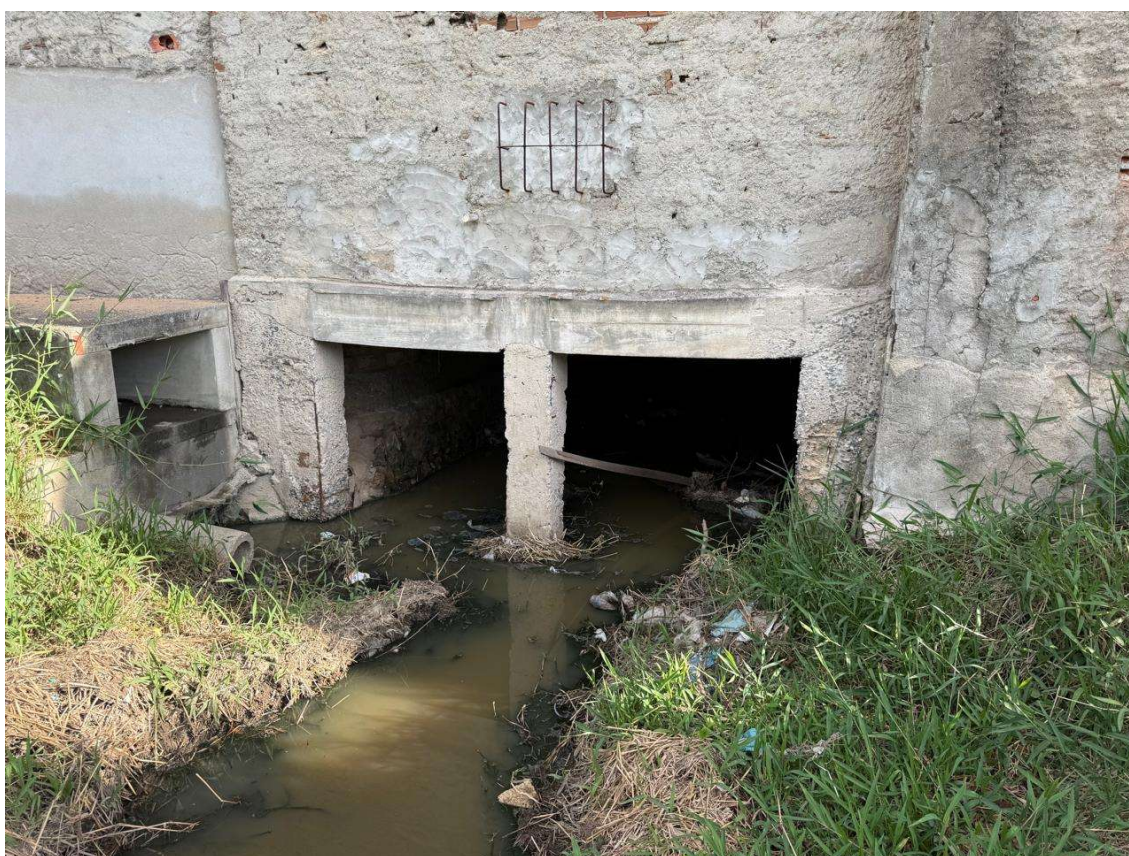
Figura 4-3 – Interferências e ocupações existentes junto à calha do canal
