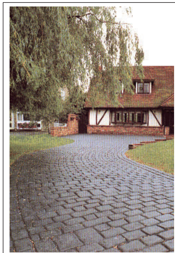
Figura 01. Pisos em concreto estampado
