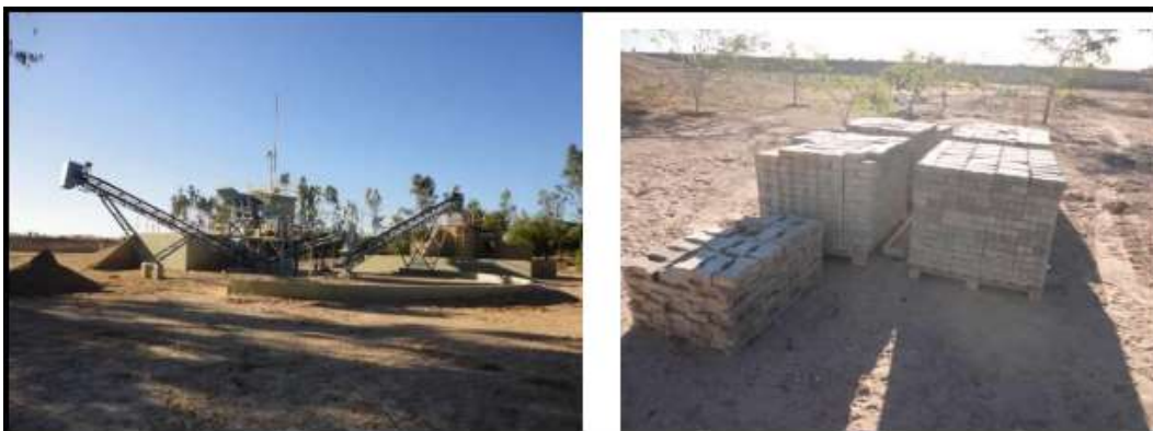
Figura 21 – Unidade de Beneficiamento de Entulho da CTR Petrolina
