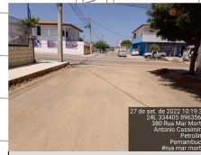
Trecho não pavimentado Rua Mar Morto E 334405 N 8963562
