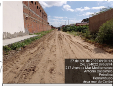
Rua não pavimentada Rua Mar Mediterrâneo E 334022 N 8963874
