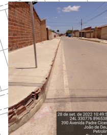
Meio-fio com sarjeta E 330776 N 8965386 Largura (LD) = 0,15 m
