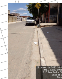
Meio-fio com sarjeta E 330863 N 8965103 Largura (LE) = 0,20 m
