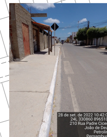
Meio-fio com sarjeta E 330860 N 8965103 Largura (LD) = 0,30 m
