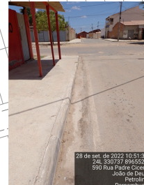
Meio-fio com sarjeta E 330737 N 8965524 Largura (LD) = 0,20 m
