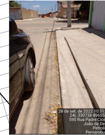
Meio-fio com sarjeta E 330738 N 8965530 Largura (LE) = 0,20 m
