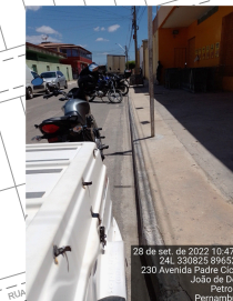
Meio-fio com sarjeta E 330825 N 8965242 Largura (LE) = 0,25 m
