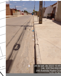
Meio-fio com sarjeta E 330784 N 8965381 Largura (LE) = 0,20 m
