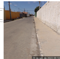
Meio-fio com sarjeta E 336661 N 8962958 Largura (LD) = 0,40 m
