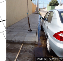
Meio-fio com sarjeta E 336662 N 8962957 Largura (LE) = 0,40 m
