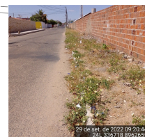
Meio-fio com sarjeta E 336718 N 8962655 Largura (LD) = 0,30 m
