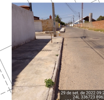
Meio-fio com sarjeta E 336723 N 8962654 Largura (LE) = 0,30 m
