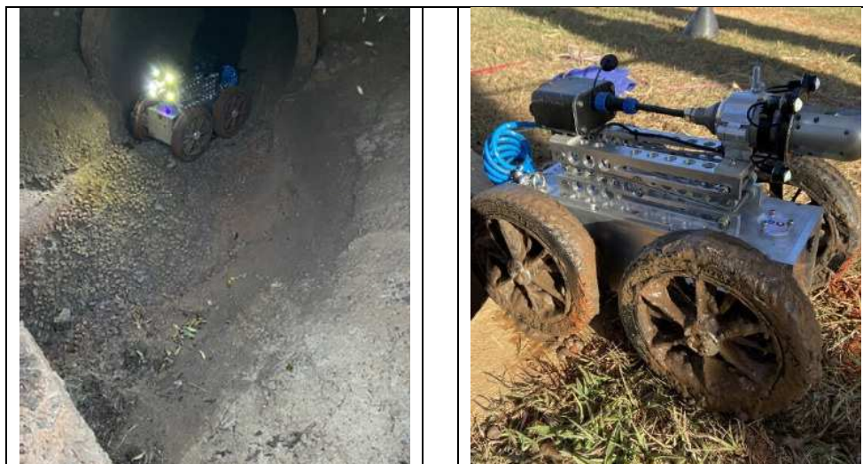
Figura 36 - Filmagem de trecho de canal fechado.
