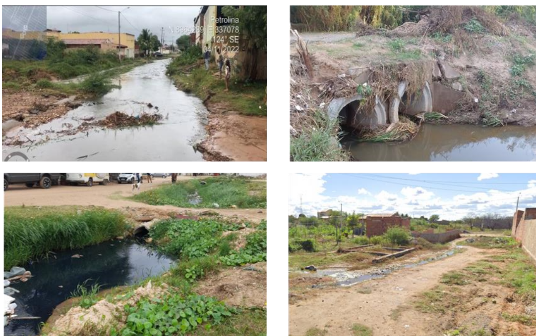
Figura 39. Problemas de macrodrenagem identificados.
