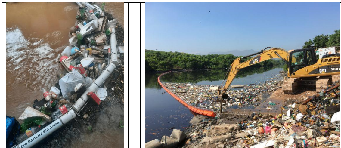
Figura 76. Processo de retenção com eco barreiras.
