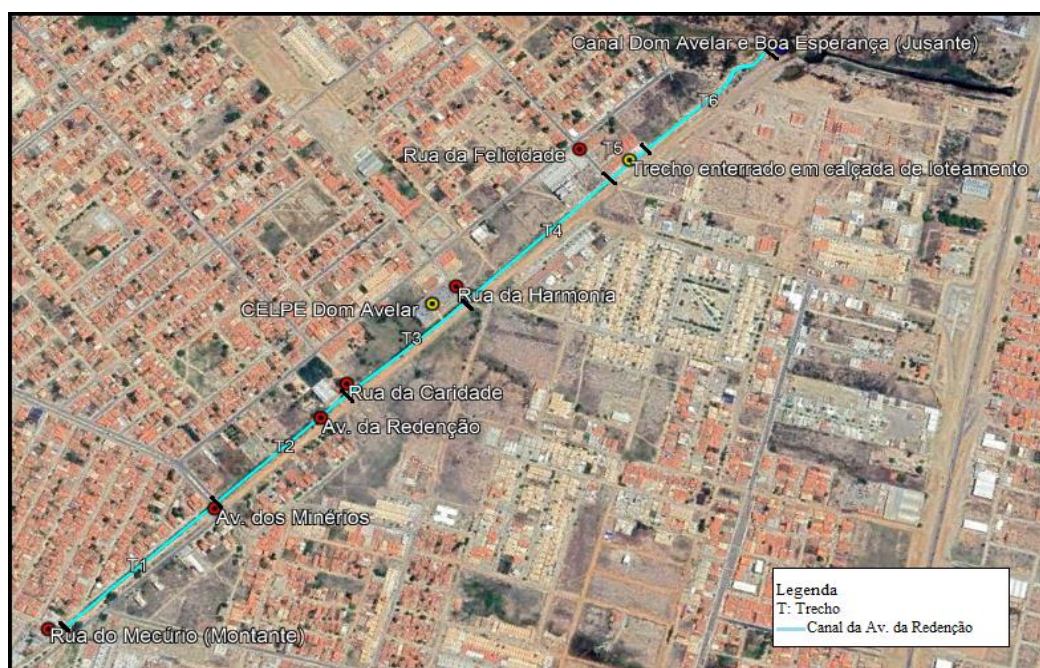
Figura 10. Canal da Av. da Redenção.
