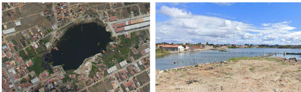
Figura 118. Lagoa já existente na área urbana de Petrolina (Lagoa Dom Avelar).
