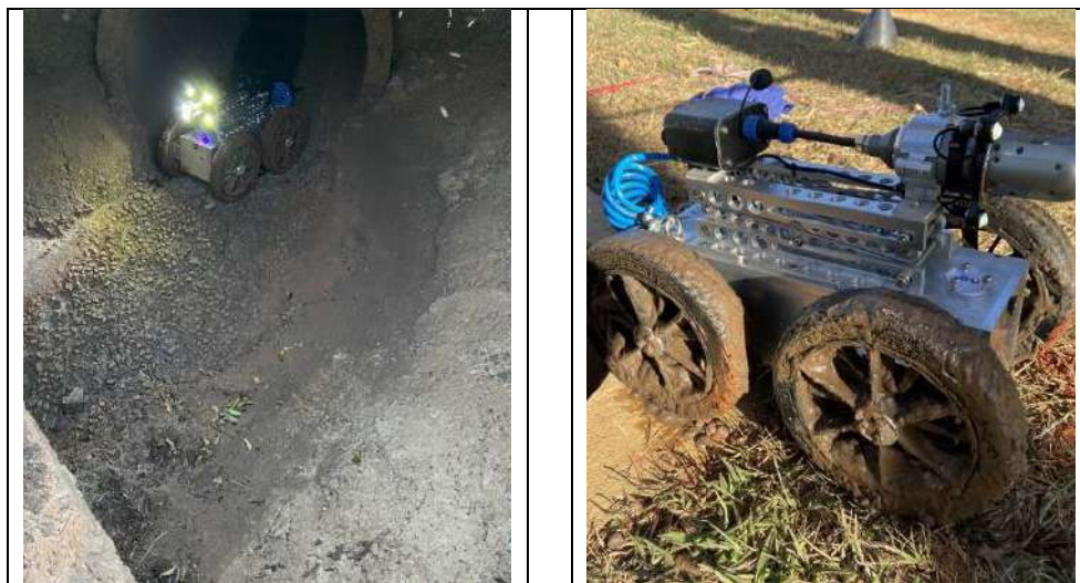
Figura 151 - Filmagem de trecho de canal fechado.
