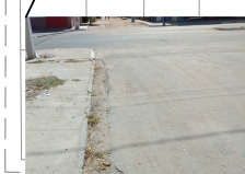
Meio-fio com sarjeta E 335570 N 8963432 Largura (LE) = 0,28 m
