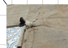
Meio-fio com sarjeta E 335703 N 8963457 Largura (LE) = 0,28 m
