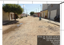
Via não pavimentada Rua Talismã (Rua 32) E 335540 N 8963427
