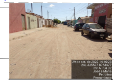
Via não pavimentada Rua Santa Marta E 335527 N 8963477
