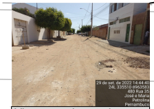
Via não pavimentada Rua São João E 335510 N 8963583
