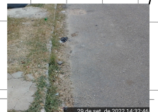
Meio-fio com sarjeta E 335806 N 8963474 Largura (LE) = 0,30 m
