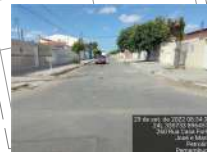
Via pavimentada E 335733 N 8964571
