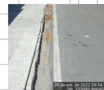
Meio-fio com sarjeta E 335995 N 8964034 Largura (LE) = 0,30 m
