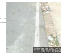
Meio-fio com sarjeta E 336142 N 8964221 Largura (LD) = 0,23 m
