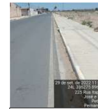
Meio-fio com sarjeta E 336275 N 8964129 Largura (LD) = 0,37 m
