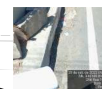
Meio-fio com sarjeta E 336149 N 8964220 Largura (LE) = 0,34 m
