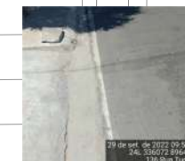
Meio-fio com sarjeta E 336072 N 8964135 Largura (LD) = 0,32 m
