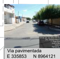
Via pavimentada E 335853 N 8964121
