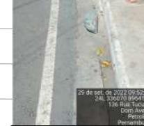
Meio-fio com sarjeta E 336070 N 8964140 Largura (LE) = 0,32 m
