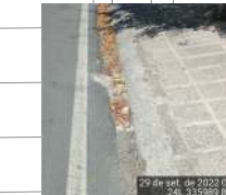
Meio-fio com sarjeta E 335989 N 8964038 Largura (LD) = 0,30 m
