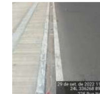
(LE) Meio-fio sem sarjeta E 336268 N 8964127
