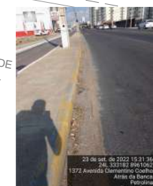
Meio-fio com sarjeta E 333182 N 8961062 Largura (LE) = 0,45 m
