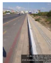
Meio-fio com sarjeta E 332799 N 8961278 Largura (LD) = 0,45 m
