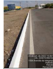
(LE) Meio-fio sem sarjeta E 333074 N 8961046
