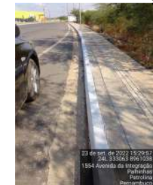
Meio-fio com sarjeta E 333063 N 8961038 Largura (LD) = 0,45 m
