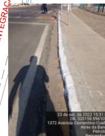
Meio-fio com sarjeta E 333158 N 8961052 Largura (LD) = 0,15 m
