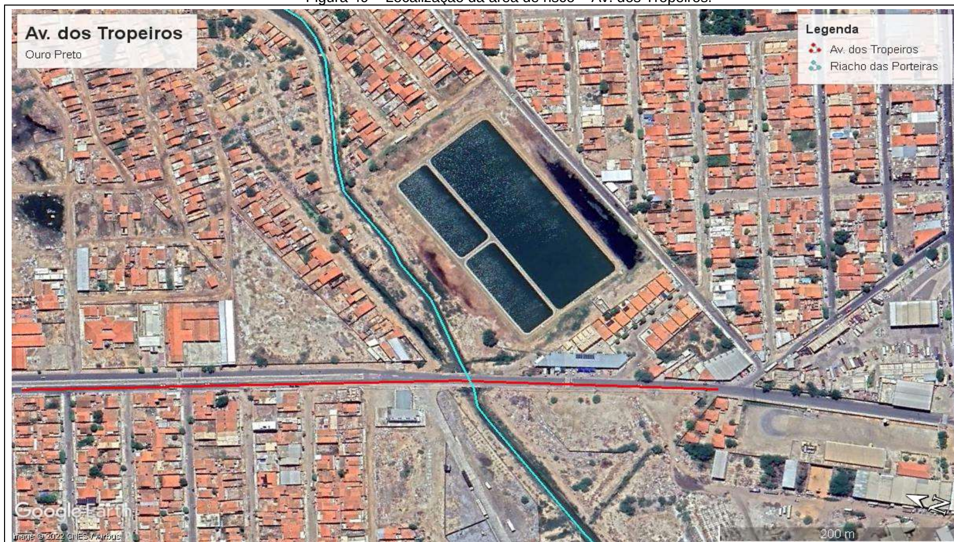
Figura 49 – Localização da área de risco – Av. dos Tropeiros.
