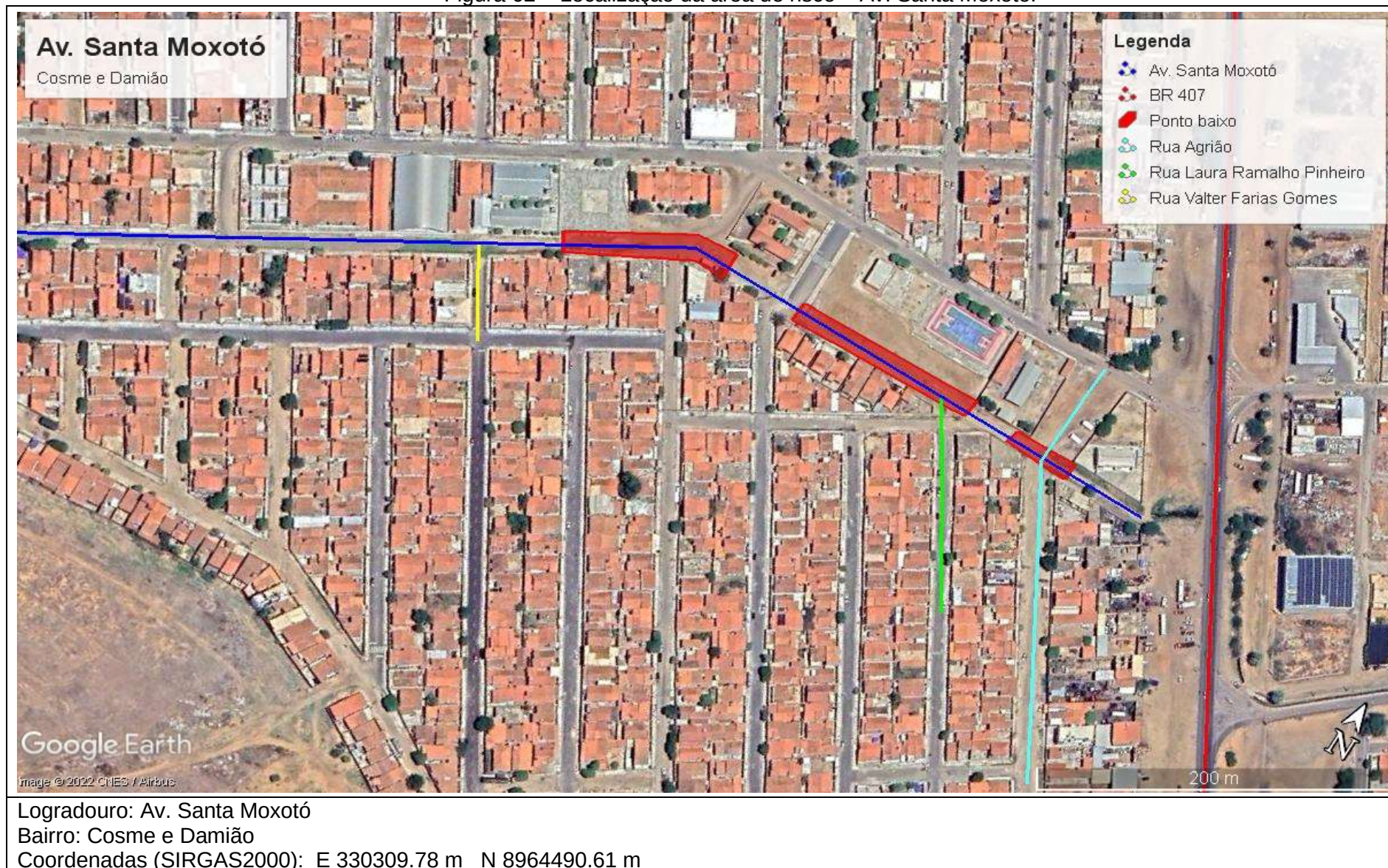
Figura 62 – Localização da área de risco – Av. Santa Moxotó.
