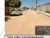
Via não pavimentada Rua do Assum-Preto E 336831 N 8965055
