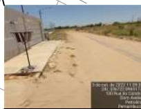
Pavimento em execução (Ausência de linha d'água) Rua do Condor E 336722 N 8965177
