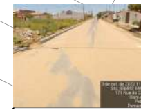
Pavimento em execução (Ausência de linha d'água) Rua do Condor E 336852 N 8965104
