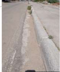
Meio-fio com sarjeta E 336306 N 8965434 Largura (LD) = 0,28 m AVALIAÇÃO EXPEDITA Condições do dispositivo █ Presença de sedimentos S Presença de entulho N Obstruções N
