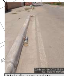
Meio-fio com sarjeta E 336227 N 8965384 Largura (LE) = 0,28 m AVALIAÇÃO EXPEDITA Condições do dispositivo █ Presença de sedimentos S Presença de entulho N Obstruções S
