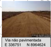
Via não pavimentada E 336751 N 8964624
