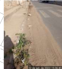
Meio-fio com sarjeta E 336964 N 8964598 Largura (LE) = 0,40 m AVALIAÇÃO EXPEDITA Condições do dispositivo ■ Presença de sedimentos S Presença de entulho N Obstruções N
