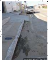
Meio-fio com sarjeta E 336862 N 8964675 Largura (LE) = 0,40 m
