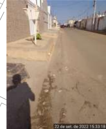
Meio-fio com sarjeta E 336873 N 8964648 Largura (LE) = 0,30 m AVALIAÇÃO EXPEDITA Condições do dispositivo ■ Presença de sedimentos S Presença de entulho N Obstruções N
