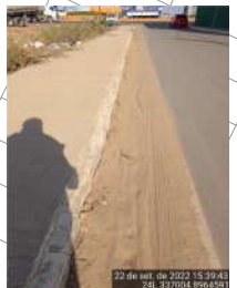
Meio-fio com sarjeta E 337004 N 8964591 Largura (LE) = 0,37 m AVALIAÇÃO EXPEDITA Condições do dispositivo ■ Presença de sedimentos S Presença de entulho N Obstruções N
