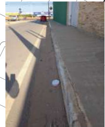
Meio-fio com sarjeta E 337004 N 8964591 Largura (LD) = 0,41 m AVALIAÇÃO EXPEDITA Condições do dispositivo ■ Presença de sedimentos S Presença de entulho N Obstruções N
