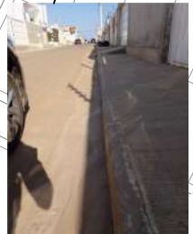
Meio-fio com sarjeta E 336873 N 8964648 Largura (LD) = 0,38 m AVALIAÇÃO EXPEDITA Condições do dispositivo ■ Presença de sedimentos S Presença de entulho N Obstruções N
