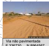
Via não pavimentada E 336730 N 8964567
