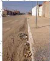
Meio-fio com sarjeta E 336866 N 8964672 Largura (LD) = 0,35 m
