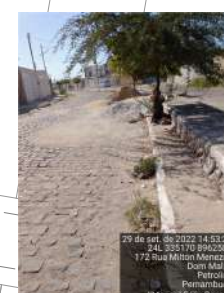
Meio-fio com sarjeta E 335170 N 8962582 Largura (LD) = 0,15 m
