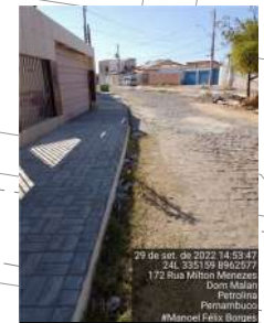
Meio-fio com sarjeta E 335159 N 8962577 Largura (LE) = 0,10 m
