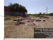
Trecho não pavimentado Rua Manoel Félix Borges E 334904 N 8962639
