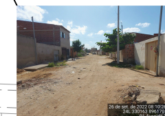
Rua não pavimentada Rua José Corrêa Moxotó E 330163 N 8961701
