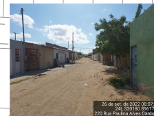
Rua não pavimentada Rua Paulina Alves Cardoso E 330180 N 8961750
