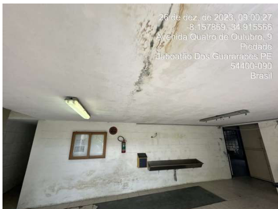
Figura 15 – Forro em gesso danificado (sala 16). Fonte: Gerência de Engenharia, 2024.
