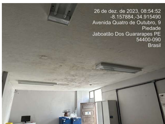
Figura 13 – Infiltração na laje da secretaria. Fonte: Gerência de Engenharia, 2024.
