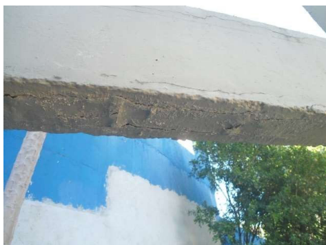
Figura 11 – Fissuras na viga do castelo d'água. Fonte: Gerência de Engenharia, 2024.
