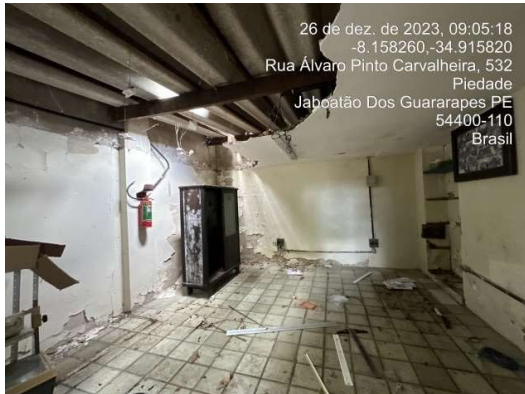
Figura 15 – Forro em gesso danificado (sala 16). Fonte: Gerência de Engenharia, 2024.
