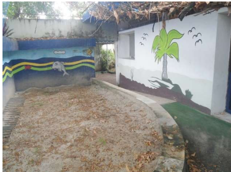
Figura 18 – Desnível e rampa entre hall e pátio infantil. Fonte: Gerência de Engenharia, 2024.
