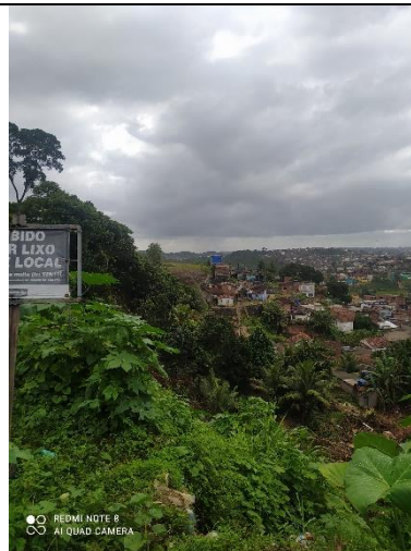
Figura 10: VEGETACAO SOBRE TALUDE
