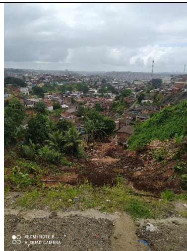
Figura 12: VALE NO TALUDE
