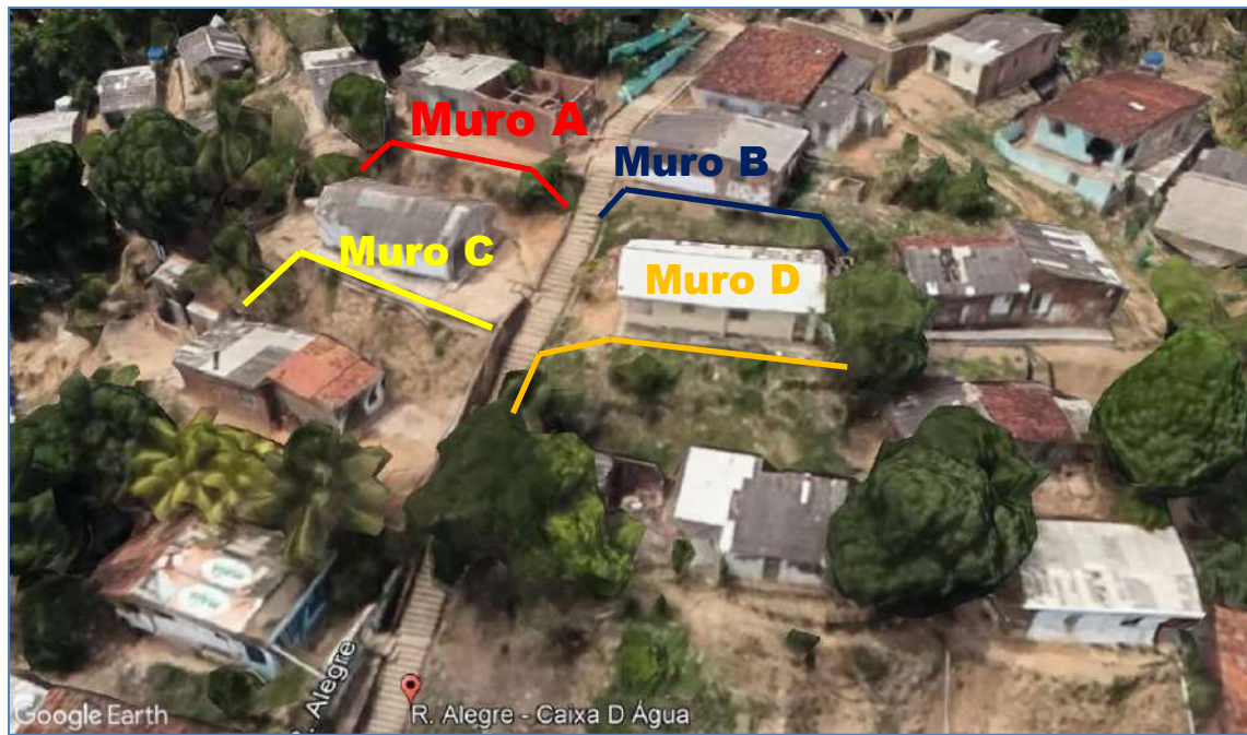
Figura 5: Imagens da locação das anomalias e implantação dos muros.
