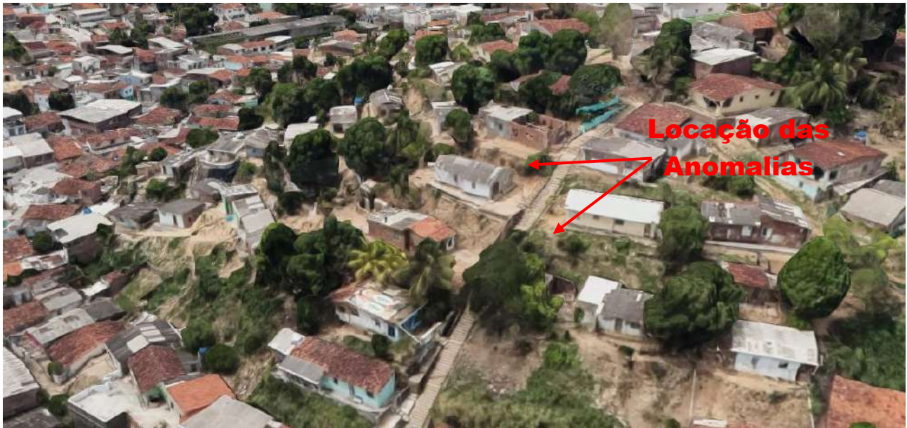
Figura 3: Localização do objeto físico da inspeção, na Rua Alegre, bairro Caixa D'água, município de Olinda-PE.
