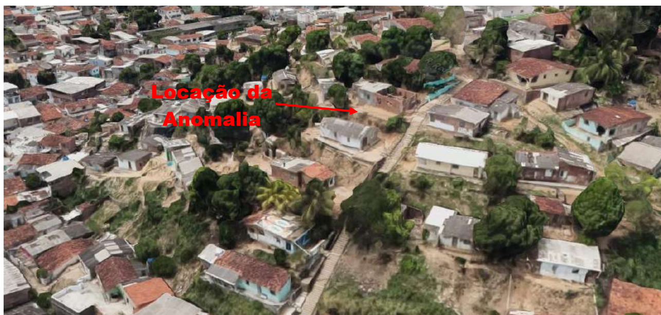
Figura 2: Localização do objeto físico da inspeção, na Rua Alegre, bairro Caixa D'água, município de Olinda-PE.
