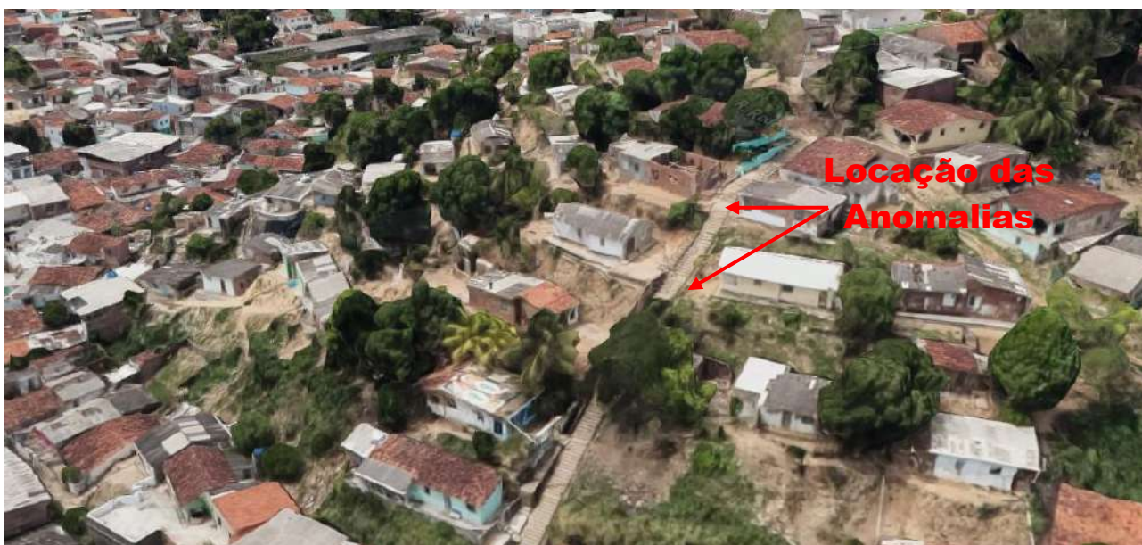
Figura 4: Localização do objeto físico da inspeção, na Rua Alegre, bairro Caixa D'água, município de Olinda-PE.
