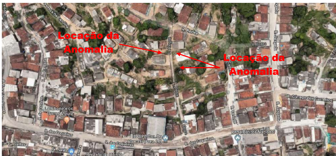
Figura 1: Localização do objeto físico da inspeção, na Rua Alegre, bairro Caixa D'água, município de Olinda-PE.
