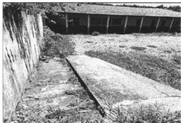
- FOTO 9 - RAMPA COM ESCADA
