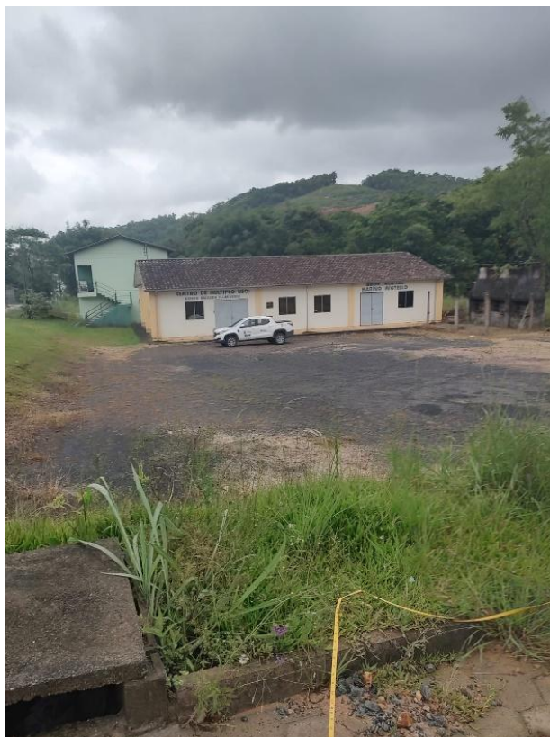
Figura 01: vista do terreno para a via pública.
