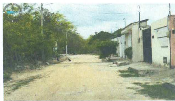
Visão final do trecho
