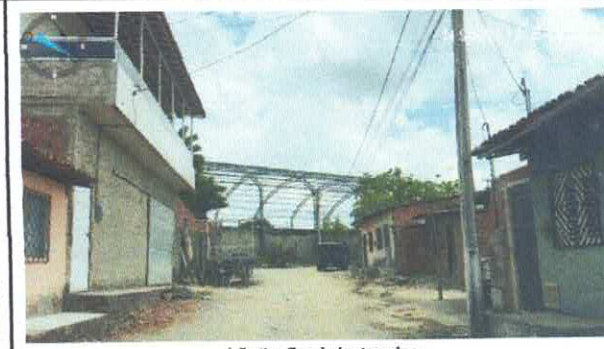
Visão final do trecho
