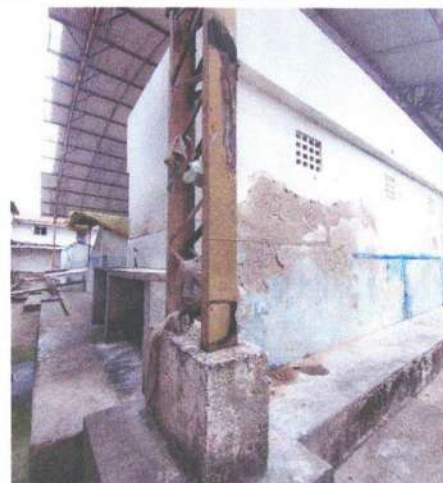
Figura 6 – Estrutura metálica e fundação.
