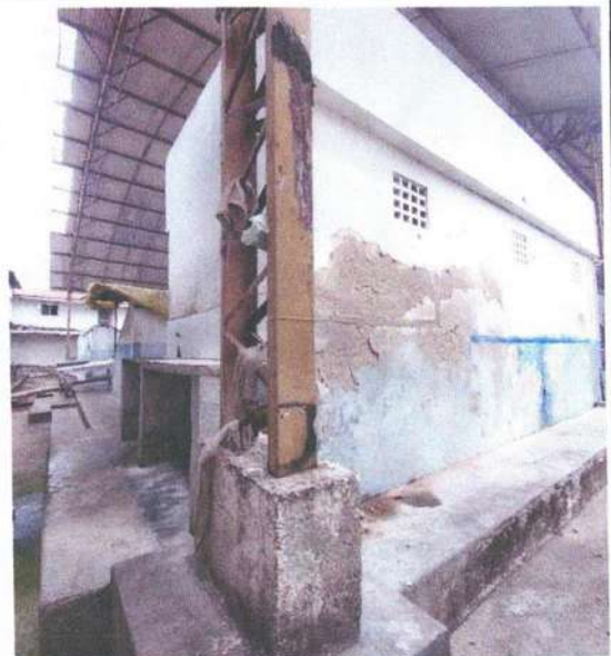
Figura 6 – Estrutura metálica e fundação.
