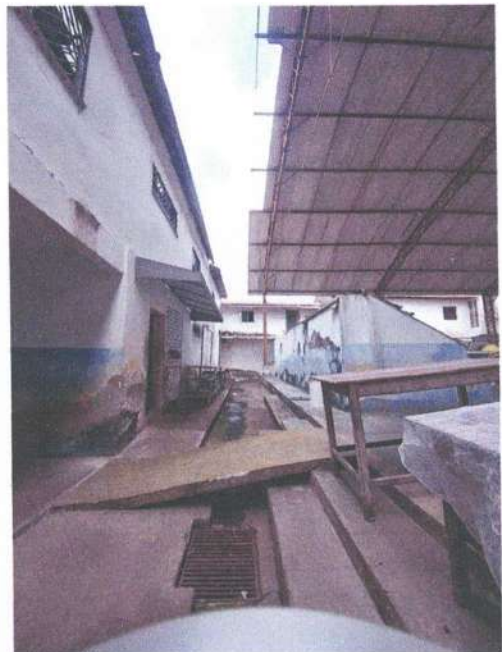
Figura 6 – Estrutura metálica e fundação.
