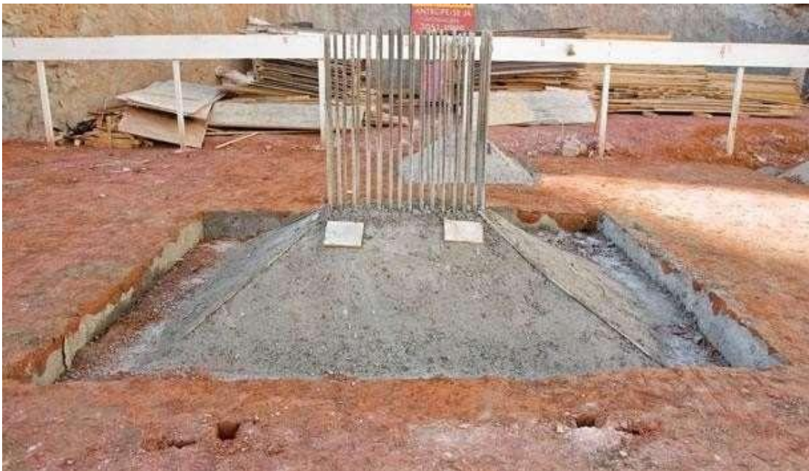
SAPATAS EM CONCRETO ARMADO DE ACORDO PROJETO ESTRUTURAL
