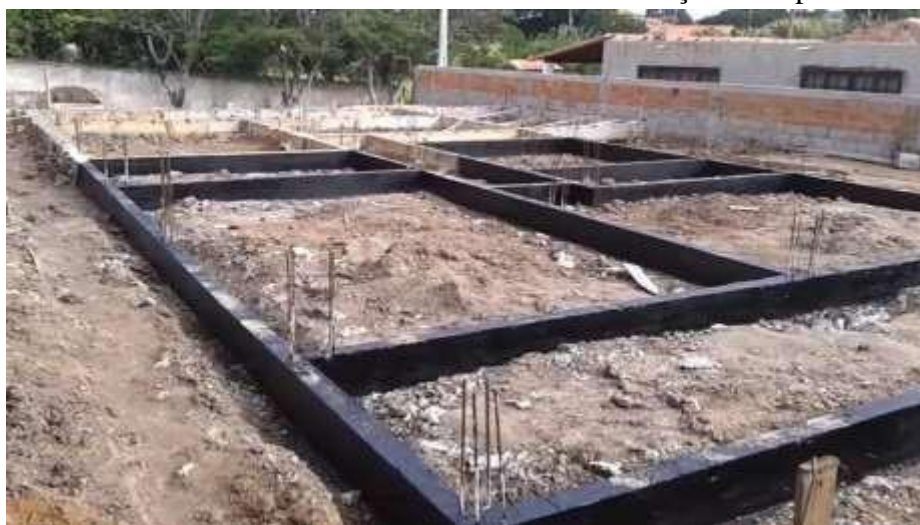
VIGAMENTO INFERIOR E FUNDAÇÕES IMPERBEABILIZADAS COM ASFÁLTO FRIO.
