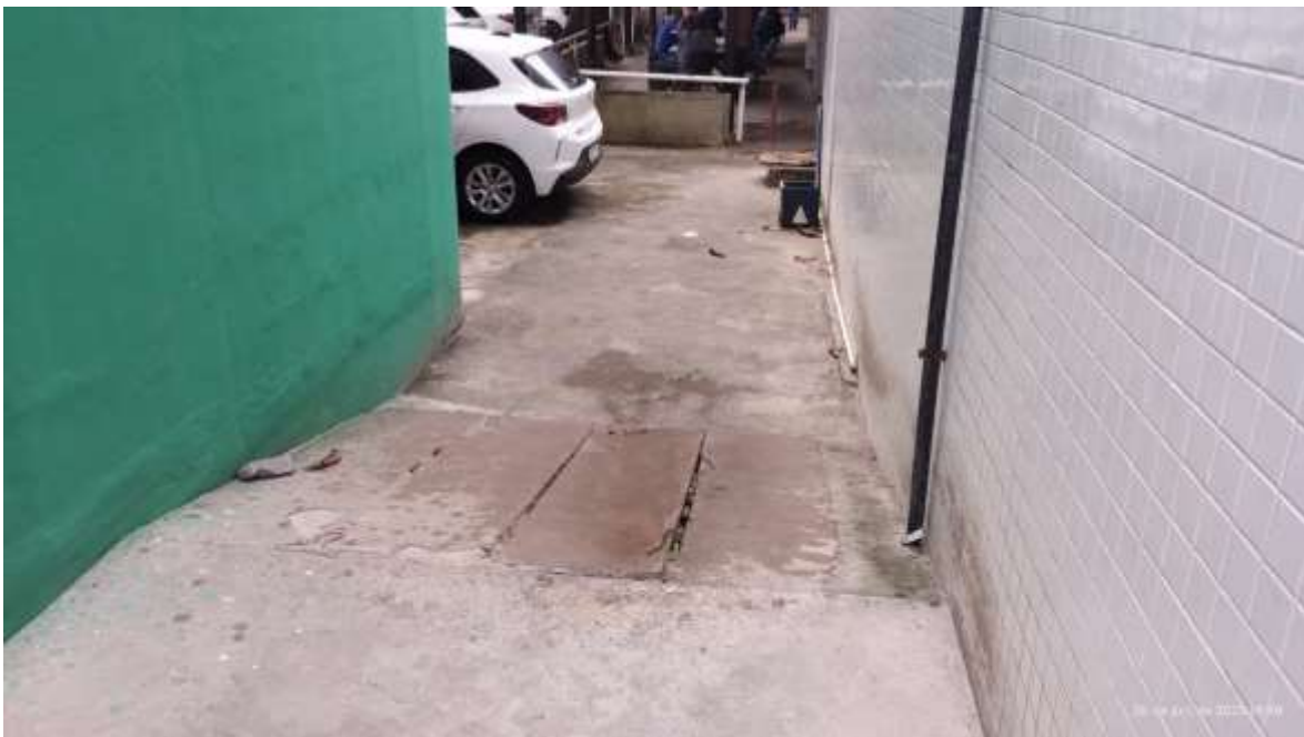
Figura 6-DETALHE DE UMA DAS RAMPAS DE SAÍDA DA ESCADA EXTERNA (ADEQUAR).
