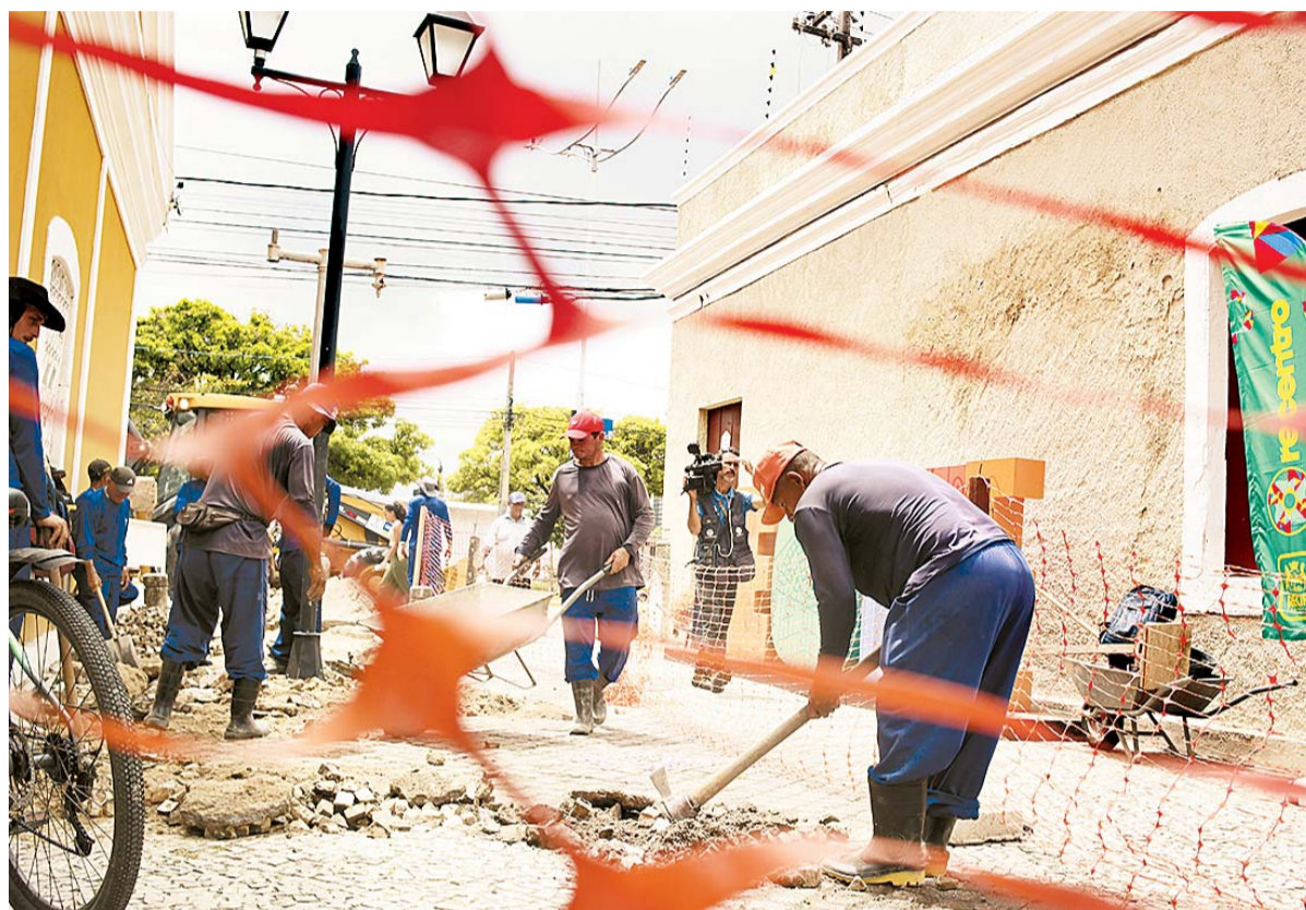
Serviço de embutimento da fiação de telecomunicações já está sendo executado
